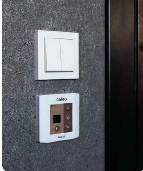
Рис. 27. Установленный терморегулятор.
