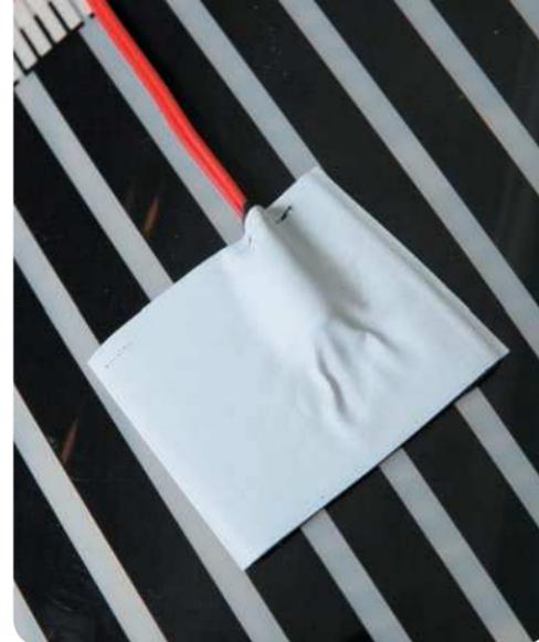
Рис. 25. Установленный и приклеенный датчик температуры пола. Вид снизу термоматки
