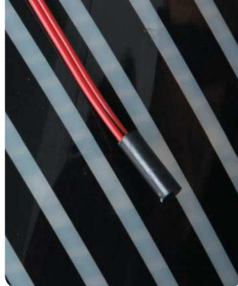
Рис. 22. Установка датчика температуры пола
