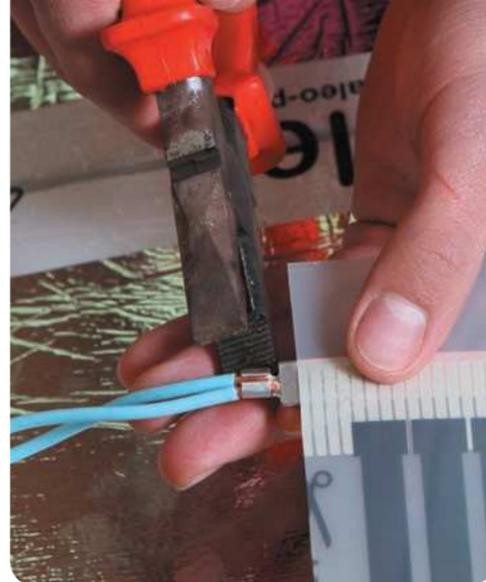
Рис. 16. Надежно зажмите провода в контактом зажиме
