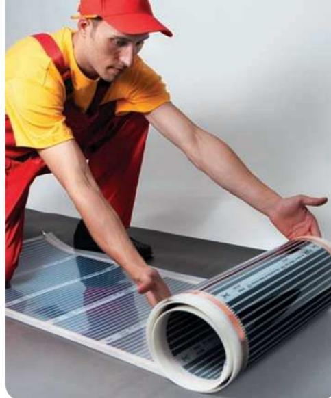
Рис. 6. Раскатывание рулона теплого пола на теплоотражающем материале
