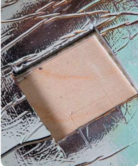
Рис. 23. Отверстие под датчик температуры пола в теплоотражающем материале
