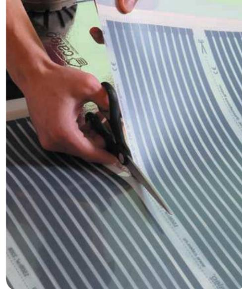
Рис. 7. Разрезание термопленки CALEO по линиям отреза
